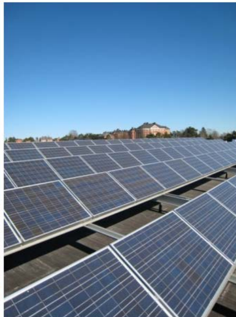
Solcellsanläggning på Tingvallahallarna
