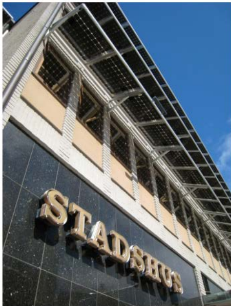
Solcellsanläggning på Stadshuset
